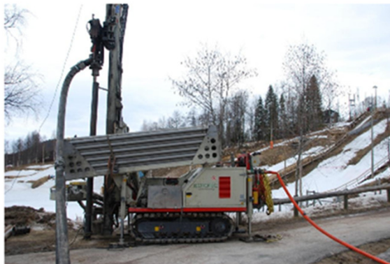
Denne maskina brukes for å bore 13 energibrønner ved Trysil sykehjem.
