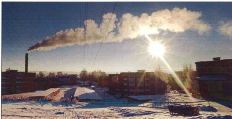
KULDESKY. Her, i et av boligområdene ved innkjøringa til Hamar sentrum, ligger varmtvannverket Børstad. Dampskyene på kalde dager er synlige på langt hold. Men anlegget er ikke lenger omstridt, heller ikke i barnehagen like ved. Foto: Foto: Trond Lillebo
