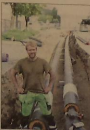
Grøftgraving: Tor Oxhovd Svalesen har hendene fulle.
