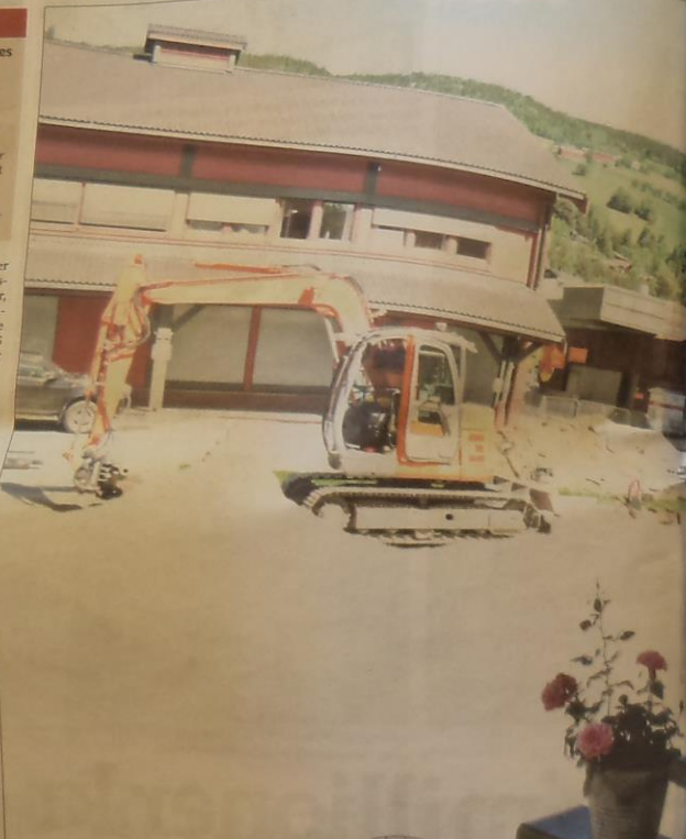
Bekymret: Leder i Fagernes Gårdeierforening og eier og driver av Fagerlund Hotell, Anne Berit Leithe-Husager, er bekymret for innvirkninga graverarbeidet vil ha på næringsdrivende i området.
